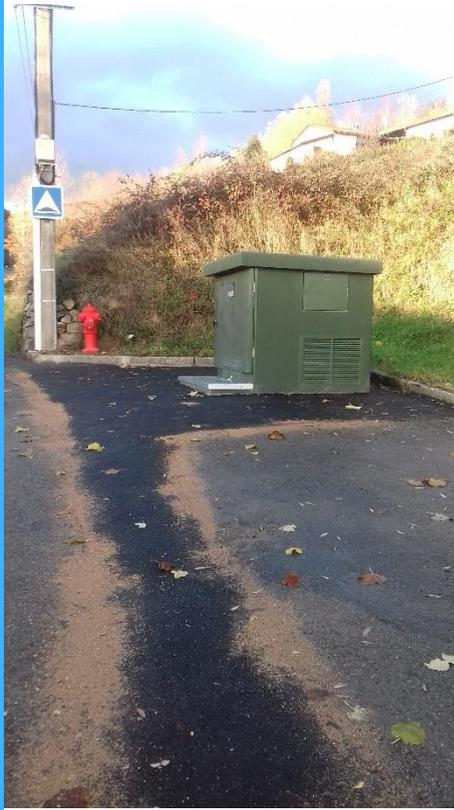
*Mise en place d'une ligne à haute tension enterrée dans la grande rue et d'un transformateur électrique sur le parking de la salle des fêtes*
