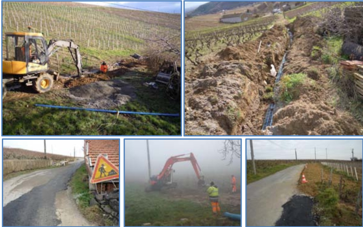
Rénovation des canalisations d'eau aux vignes :
