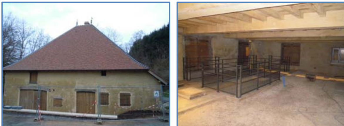
Rénovation du moulin-scierie :
