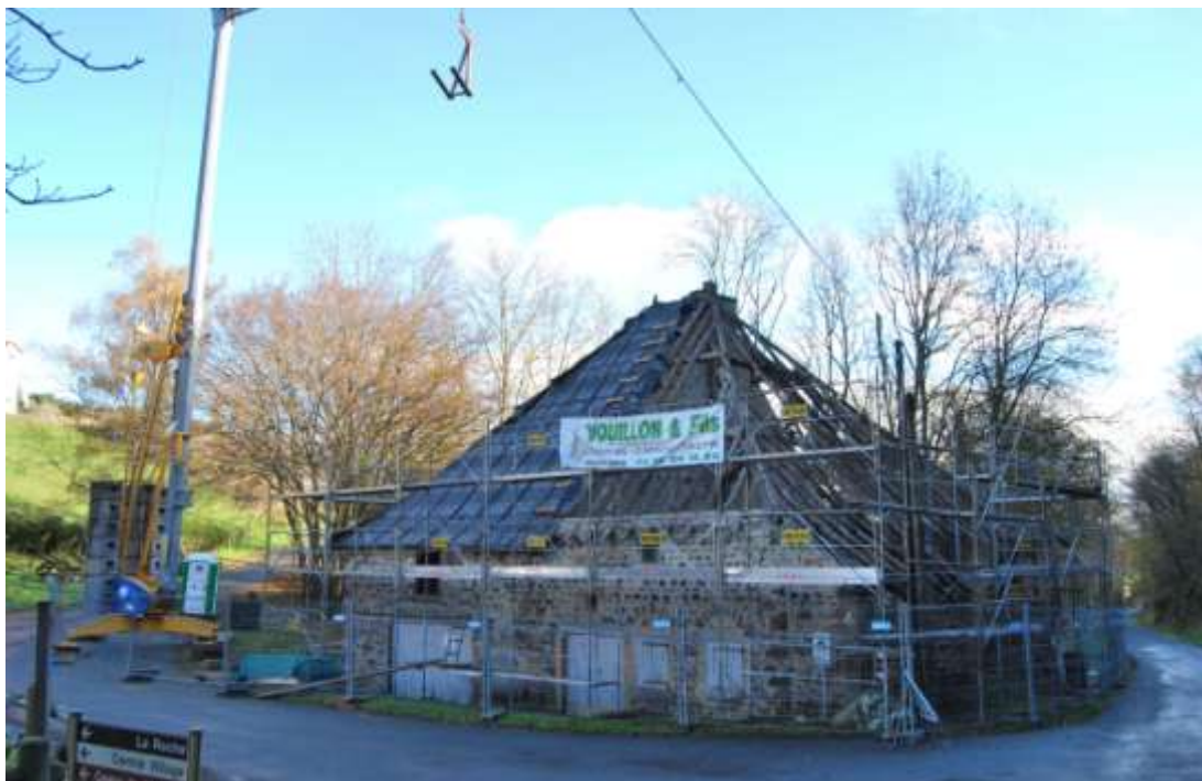
Les travaux ont débuté fin novembre (photo JPG)
