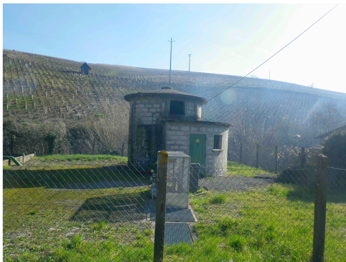
Station d'épuration de Jullié
