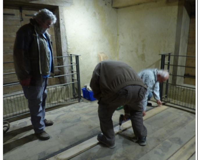
Le banc de scie était posé sur des rails incomplets et non fixés. Après l'ajout d'une épaisseur de bois sous un rail, afin d'obtenir un banc parfaitement horizontal, il a fallu meuler, aléser, visser...
