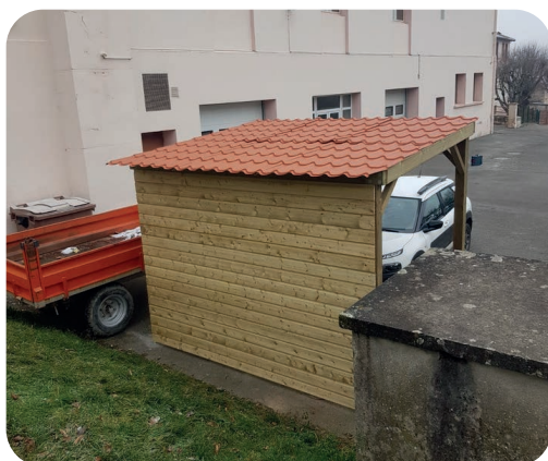
Construction d'un abri à vélo derrière la salle des fêtes.
