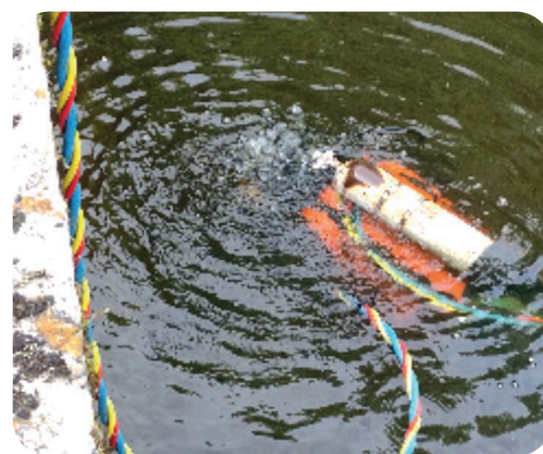
Expertise des vannes de l'étang et recherche des fuites .
