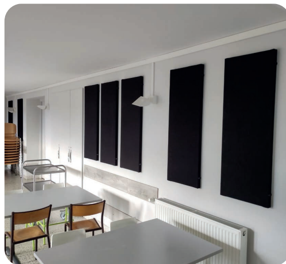
Pose de panneaux phoniques dans le foyer.
